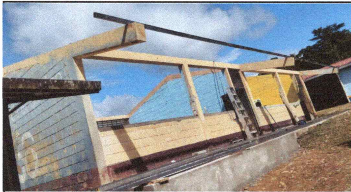
Foto1: Se observa intalación de estructura metalica de dos aulas
