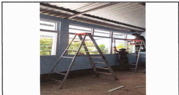
Foto 6: Se observa el proceso de instalacion de ventanas PVC
